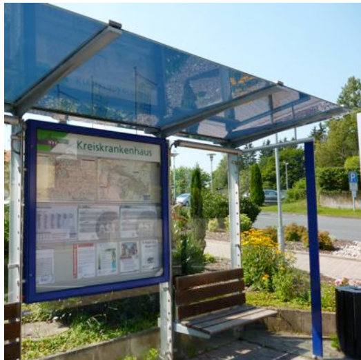
Foto 2: Umrüstungsmaßnahme Haltestelle Kreiskrankenhaus Eschwege (C. Röhrig)
